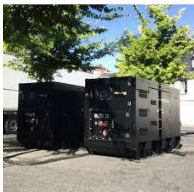
La solution Twin pack couple 2 groupes électrogènes. Elle permet d'avoir un relais si un des groupes électrogènes tombait en panne.
